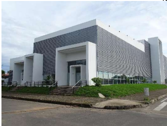
Fotografías N° 4: Terminación Palacio Municipal
