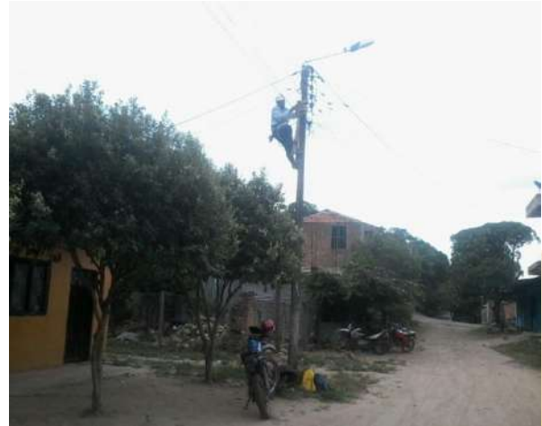
Fotografía N° 1: Mantenimiento alumbrado público
